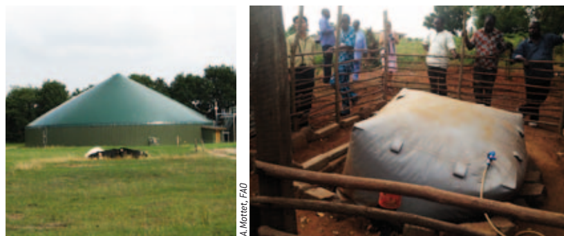
Ces unités de méthanisation (en Allemagne, à gauche, et au Ghana, à droite), de tailles très différentes, produisent une énergie renouvelable (biogaz) à partir des effluents d'élevage.
